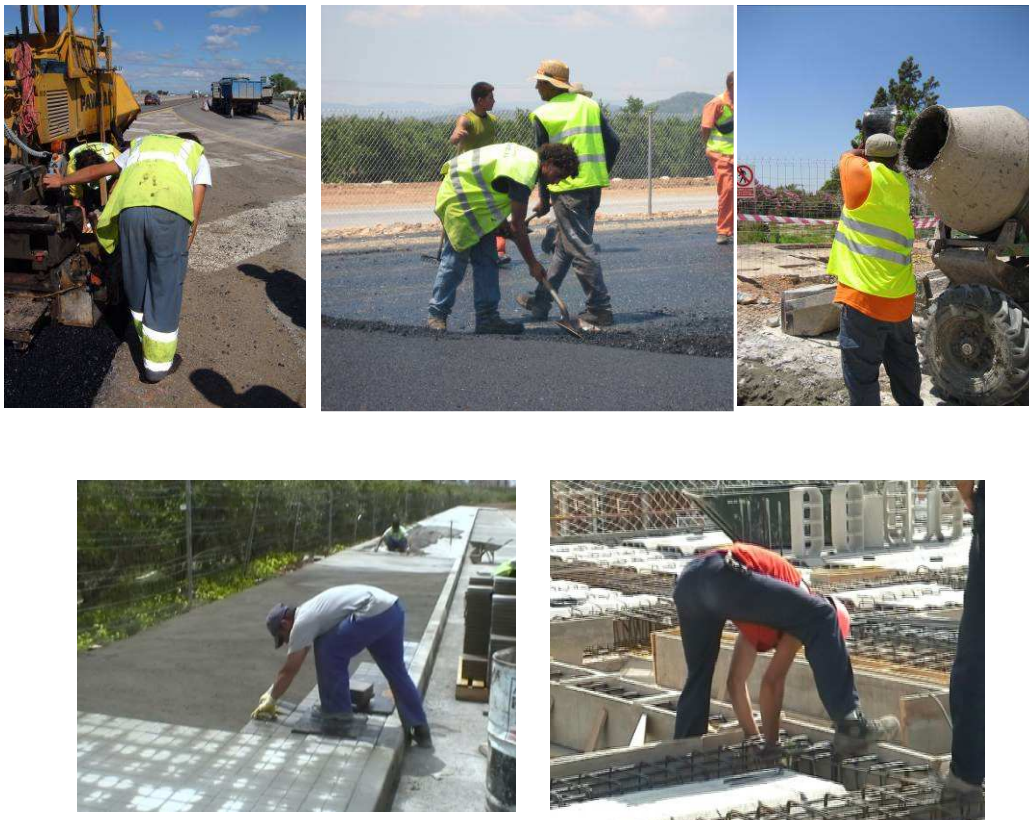
Figura: Posturas de trabajo forzadas en el sector de la construcción
